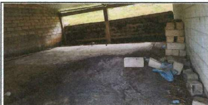
Foto 6: Se necesita la colocacion de fundicion de torta de concreto.
